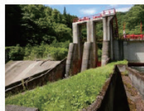
稲荷頭首工 （前回の更新から50年近く経過）
