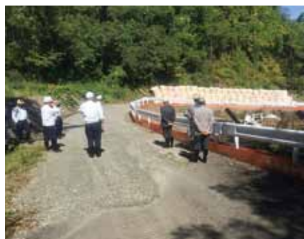
山王海2号線仮復旧工事現地踏査
