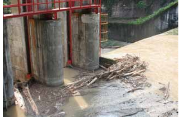
豪雨により土砂、流木堆積 稲荷頭首工
