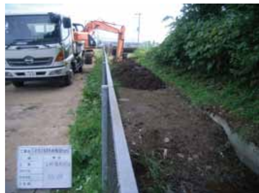
査定前着工状況 南幹線用水路(1工区)
