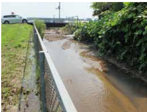
豪雨により水路に土砂流入 紫波町土館地内
