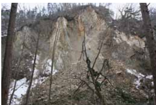
一時は葛丸ダム法面崩落と報道されたダム下流の葛丸川右岸の崩落現場
