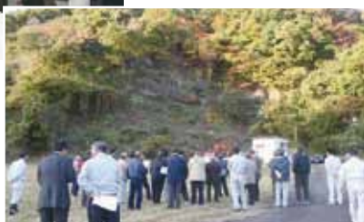
葛丸ダム放流バルブ室 法面保護工事現場
