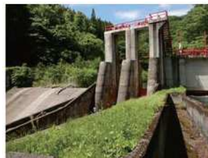
稲荷頭首工 （前回の更新から50年近く経過）
