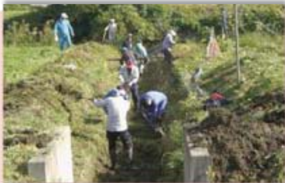
排水路の土砂上げを実施
