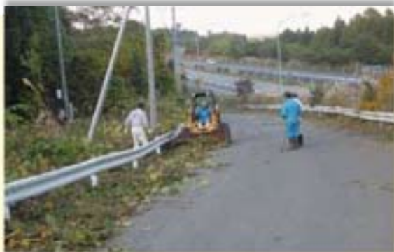
重機を使用して道路清掃作業
