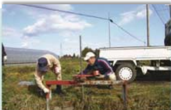
施設の長寿命化を図るため 水門の塗装作業を実施
