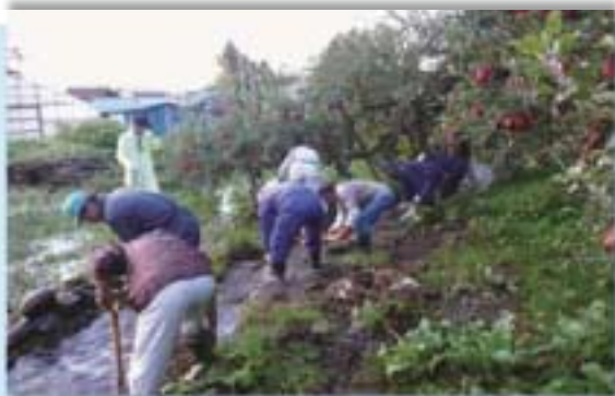
秋雨前線による大雨災害後に 開水路の土砂上げを実施
